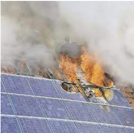
Cosa può accadere in impianti tradizionali
